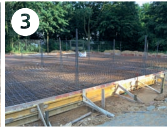
3 Die Bewehrung der Bodenplatte ist verlegt.
