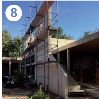
Die Stahlbetonwände im 1. Obergeschoss sind fertiggestellt.
