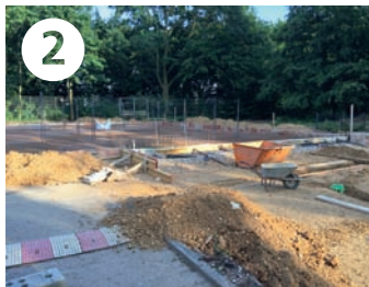
2 Die Bewehrung für die Bodenplatte der ersten zwei Gruppen ist bewehrt. Im Bereich der dritten Gruppe werden die Grundleitungen verlegt.
