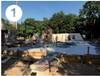
1 28.6. Die Bodenplatte ist fertiggestellt, der Aufzugsschacht betoniert und die ersten Mauerwerkswände stehen schon.
