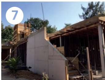
7 Aufgang für die Dienstwohnung im 1. Obergeschoss. Im Hintergrund steht schon der Aufzugsschacht im 1. OG
