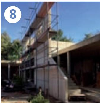
Da die Außenwände und das Dach als Holztragwerk hergesetelt werden, steht erst mal nur das Rohbauskelett. Sukzessive rollen große LKW auf den Platz, die ganze Aussenwände antransportieren, die mit dem Kran direkt an Ort und Stelle montiert werden. Direkt im Anschluss werden die Fenster eingebaut. Daher erwarten wir, dass die Gebäudehülle bald geschlossen wird, so dass die Ausbaurbeiten beginnen können.
